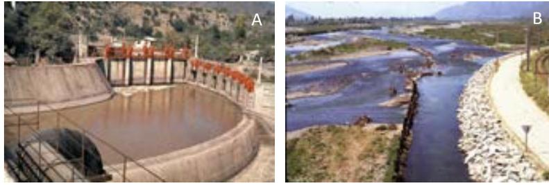
Figura 15. [A] Bocatoma Tecnificada; [B] Bocatoma Tradicional
