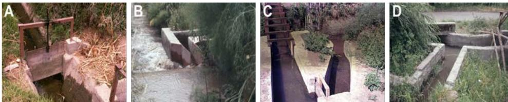
Figura 24. Sistemas de Distribución: [A] Compuerta; [B] Marco Partidor; [C] Compuerta Lateral; [D] Múltiple
